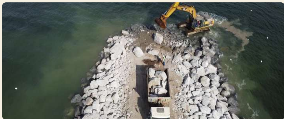
Obra de colocação de pedras nos guias correntes do Canal de Itaipu, 2026
